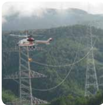
▲送電線をつなぐヘリコプター
