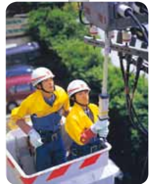
▲配電線を点検する人 電気を運ぶ電線や電柱に異常がないか点検したり修理をして、みんながいつでも電気を使えるようにしています。台風や雷などで万一、電気が止まった場合でも、すぐに直せるように準備しています。
